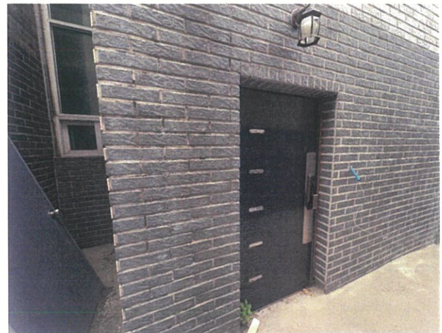
일련번호 아 전경
